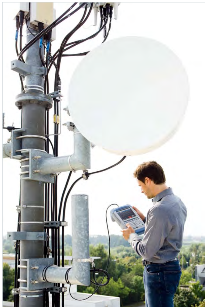
安装和维护发射机基站时使用FSH。
